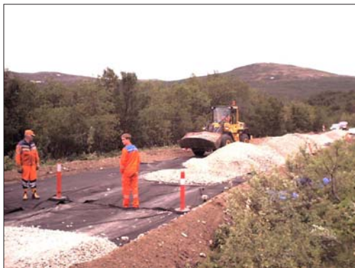
Figur C4-2a. Intern transport av Skumglas (©HASO- POR std).
