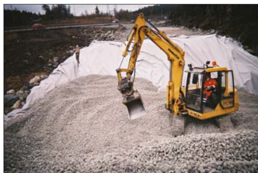
Figur C1-2b. Planering och packning av skumglaslet med grävmaskin.
